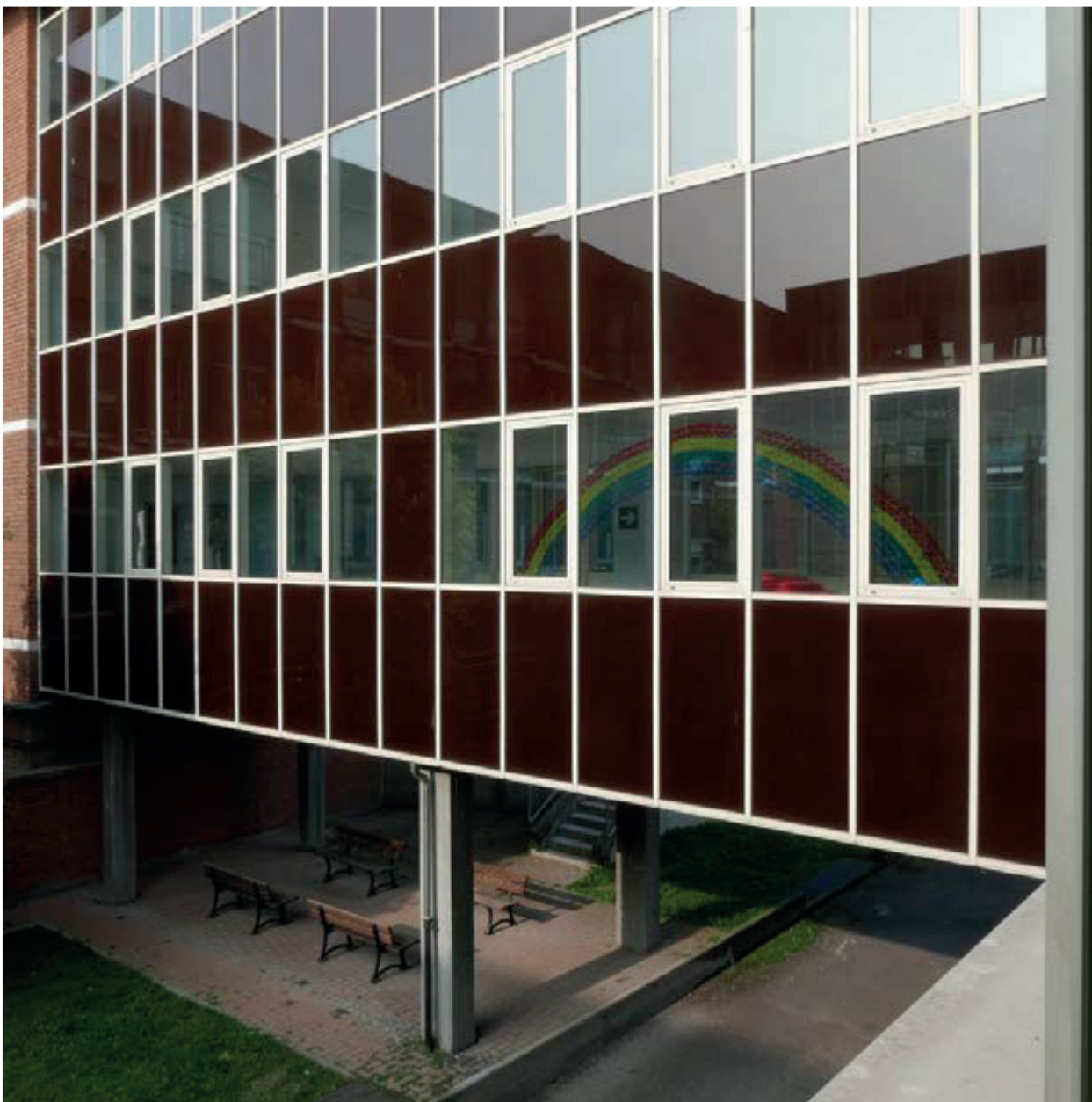
Foto 9 Ospedale Infantile - ingresso (@elenafranco) Foto 10 Ospedale Infantile - particolare nuovo padiglione (@elenafranco)
