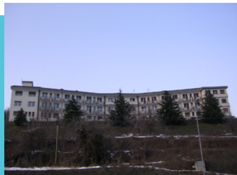
FIG. 10: Ex Ospedale Civile di Demonte
