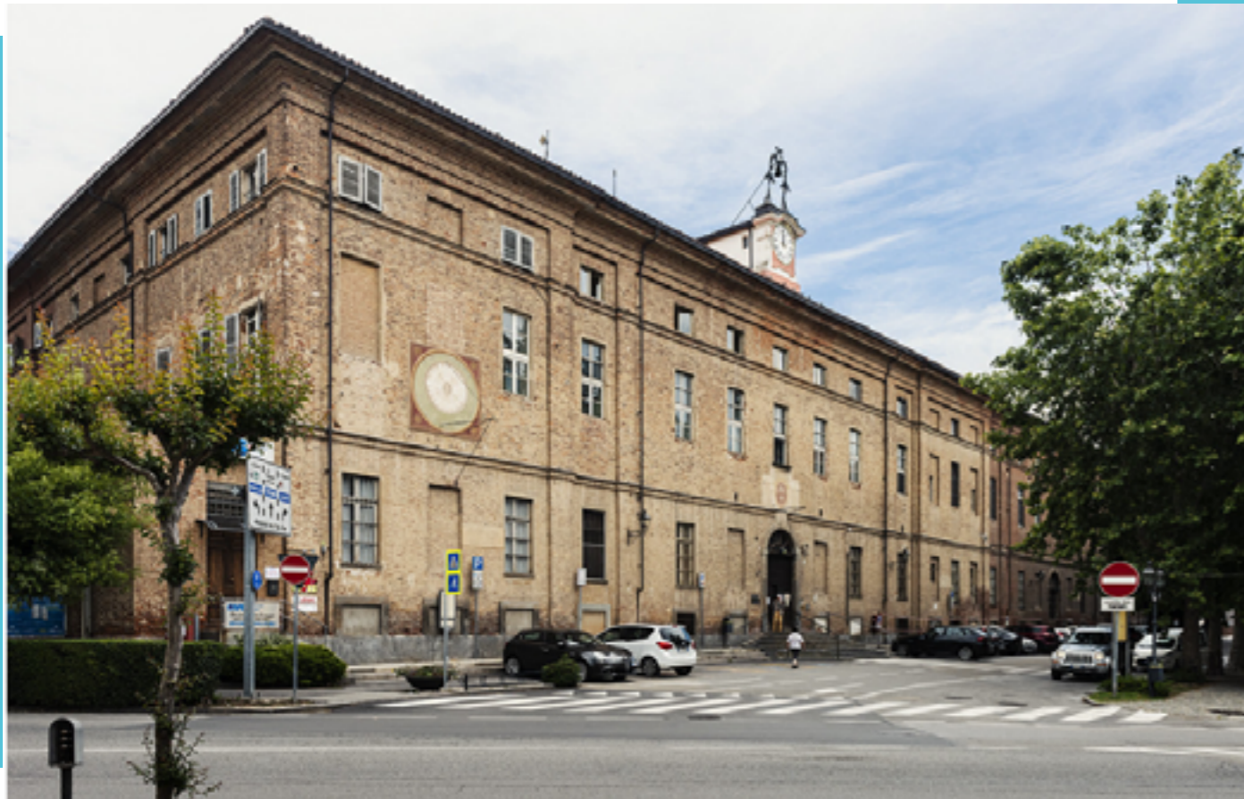
FIG. 4: Ospedale Santo Spirito di Bra – facciata dell'ingresso principale
