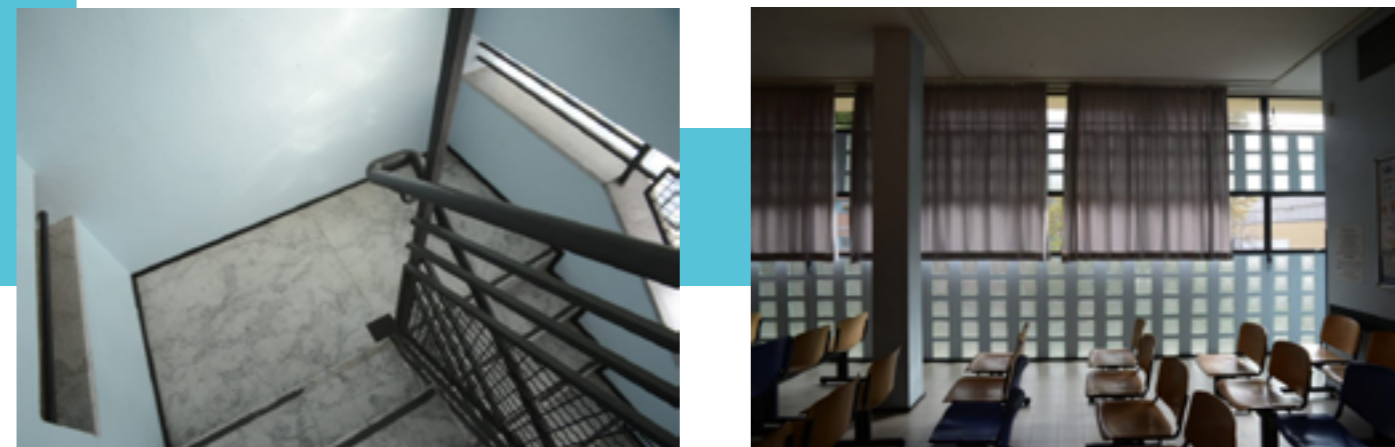
FIGG. 23 - 24: Poliambulatorio Gardella ex Dispensario antitubercolare – particolari della struttura (@elenafranco)
