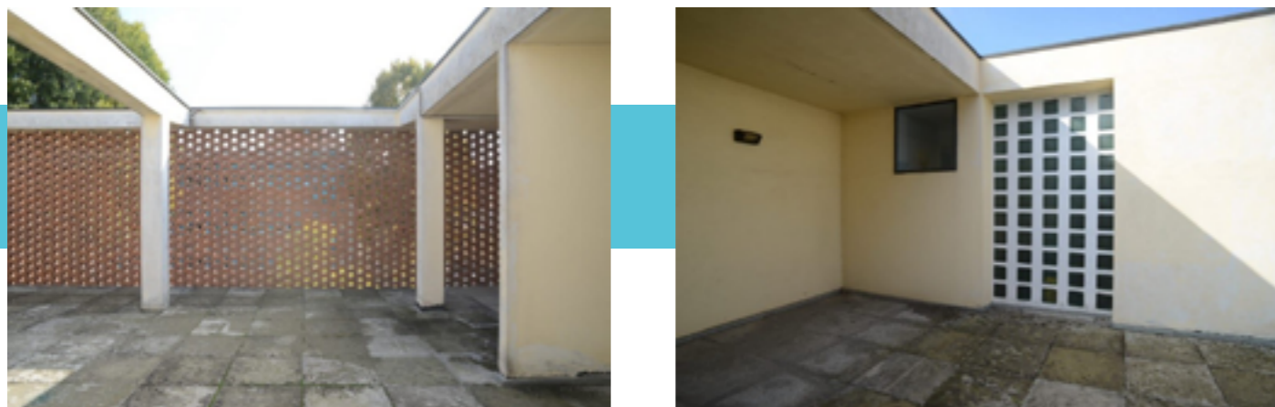
FIGG. 21 - 22: Poliambulatorio Gardella ex Dispensario antitubercolare – particolari della struttura (@elenafranco)
