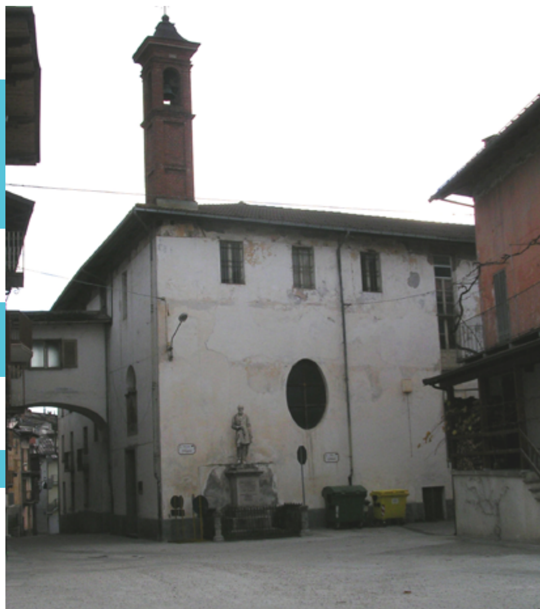
FIG. 9: Ex Ospedale Civile di Demonte
