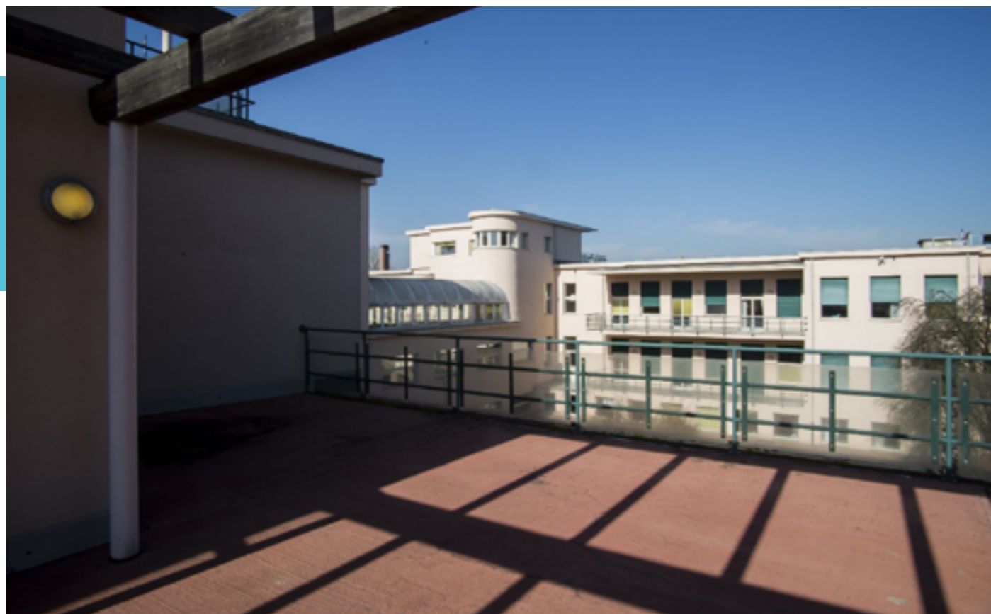
FIG. 18: Centro Riabilitativo Polifunzionale Teresio Borsalino – veduta da una delle terrazze del corpo principale (@elenafranco)
