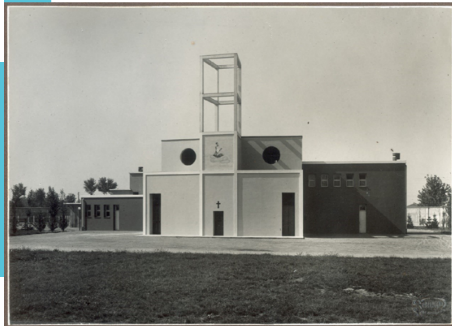
FIG. 17: Chiesa del Sanatorio – si evidenzia il particolare campanile a traliccio, in cemento armato ma estremamente leggero (Fondo Sartorio)
