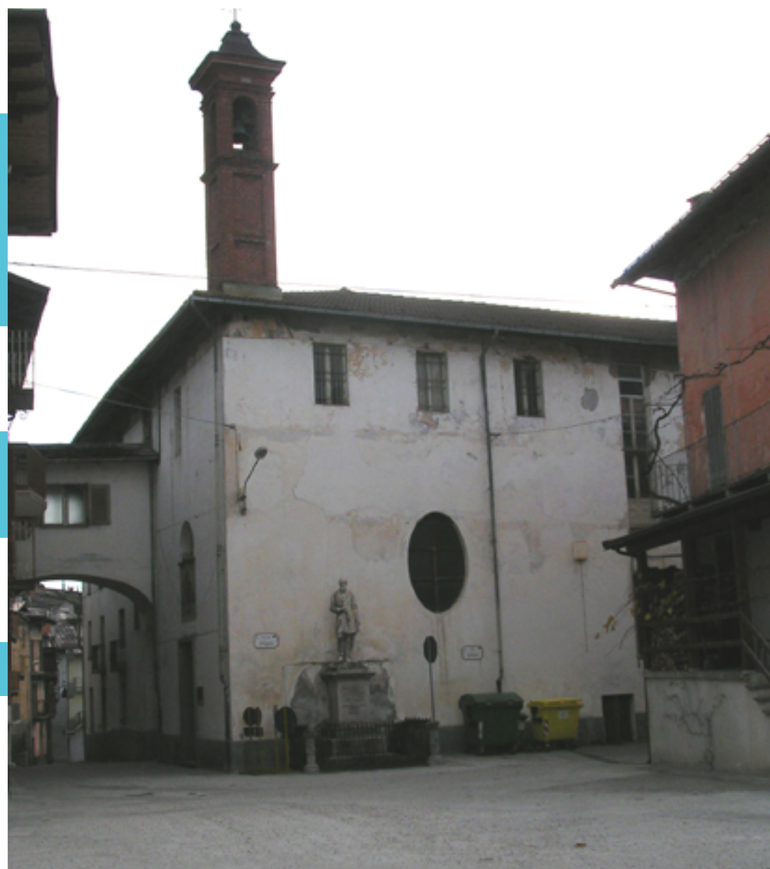
FIG. 9: Ex Ospedale Civile di Demonte
