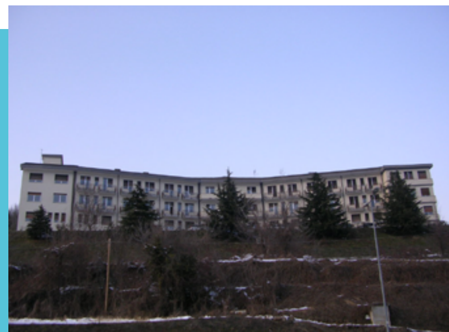
FIG. 10: Ex Ospedale Civile di Demonte
